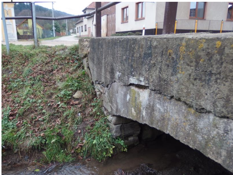
Popraskané levé křídlo mostu
